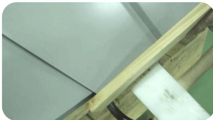
Подготовленную панель Кликфальца установите на скат, защелкните замок. Используя брусок и киянку, выровняйте панель относительно картин, установленных ранее.
