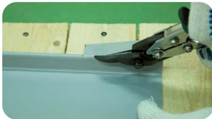
Обрежьте нижние части обоих замков накрываемой картины (картина ①, рис.1) на расстоянии 100 мм от края.
