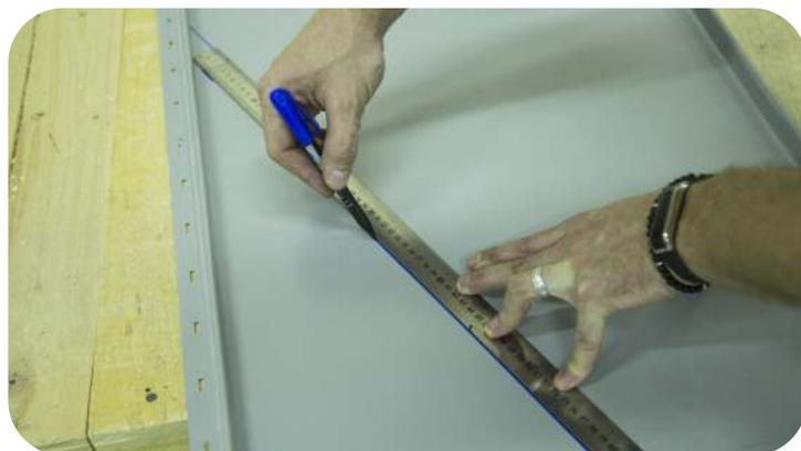
Из деревянных брусков сколотите шаблон. Зафиксируйте на шаблоне угол между линией ендовы и картиной. Используя шаблон, перенесите на панель линию отреза.
