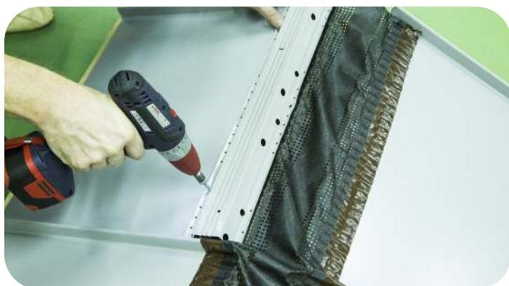
Закрепите между замками панелей Кликфальц планку вентпрогона опорного на кровельные саморезы.
