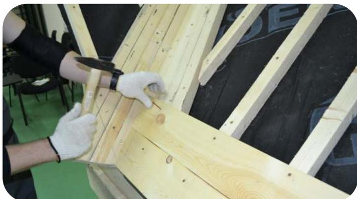
На контрбрус смонтируйте доски обрешетки. Для монтажа обрешетки используйте доски с влажностью не более 20%. Минимальная толщина доски, используемой для обрешетки – 25 мм.
