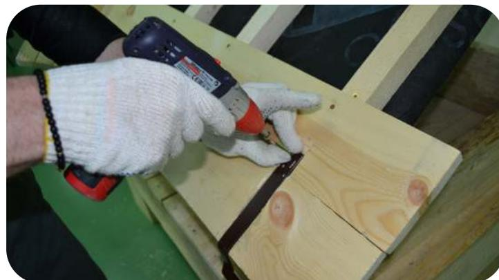
Закрепите подготовленные крюки водосточной системы в пазах оцинкованными саморезами. Ни крюки, ни саморезы не должны выступать выше обрешетки.
