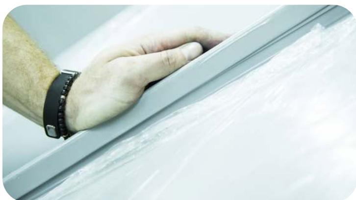
Подготовленную панель установите на скат, оставив зазор 5мм. между карнизной планкой и загибом панели, защелкните замок. Используя брусок и киянку, выровняйте панель относительно первой.
