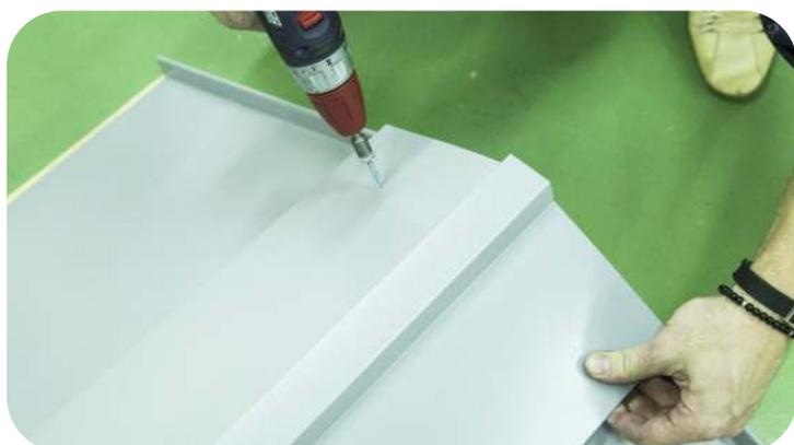
Закрепите Конек 150x40x150 к планке вентпрогона опорного кровельными саморезами.
