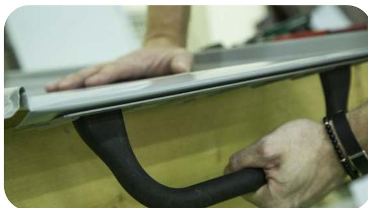
Загните подрезанный край картины внутрь с помощью инструмента для загиба карнизного свеса. Проконтролируйте **угол загиба**, он должен составлять **15-30°**.
